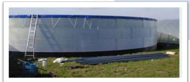
Figura 3 Tanque de agua ( www.waterportaal.be ).
